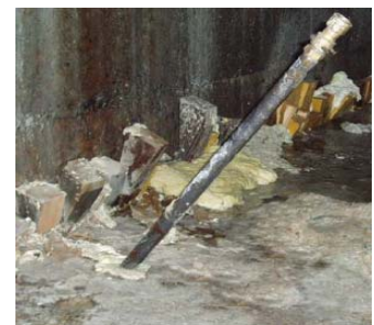
施工例(注入後)
