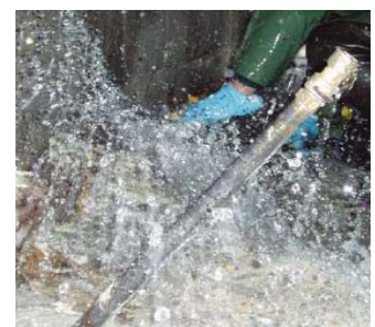
施工例(注入前)
